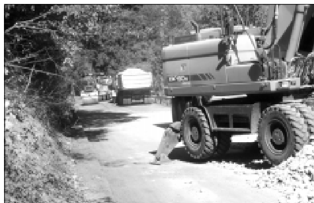
Ремонт на пътя Твърдица - Елена
